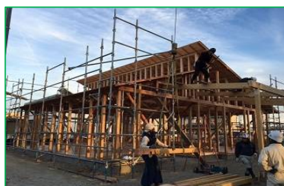
棟上げの様子
